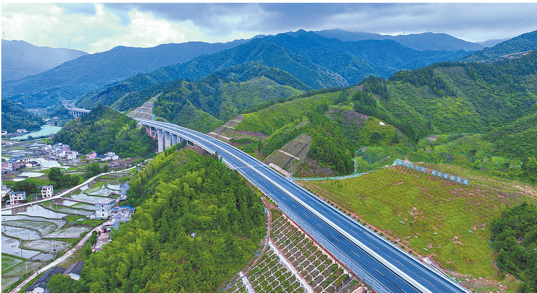
5月21日，我省在建的遂大高速公路项目沿线经过生态修复后绿意盎然。该项目积极对沿线边坡、取土场等地开展植被恢复工作，有效提升植被覆盖率，防止水土流失。通讯员 李建平摄
