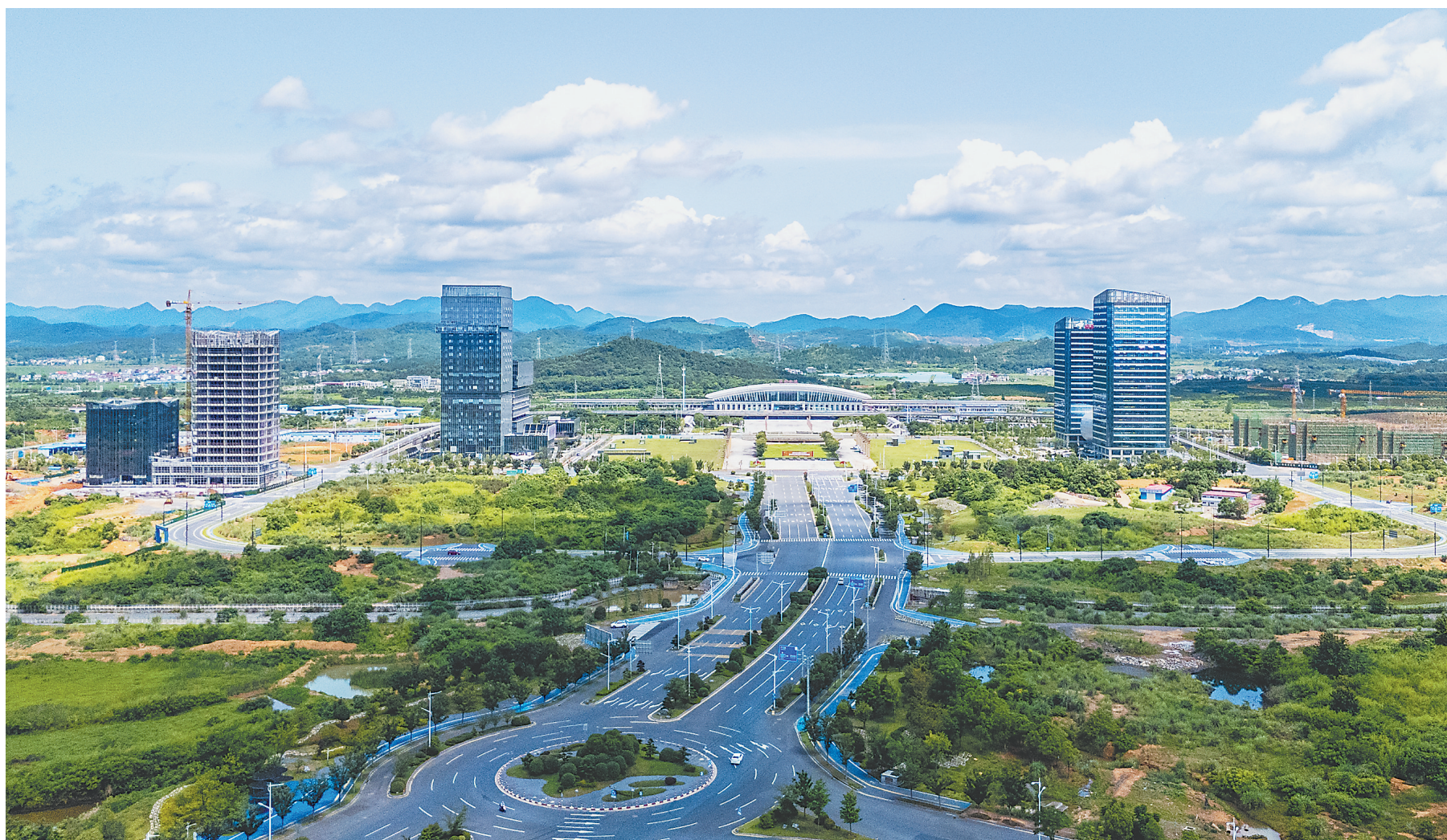
近年来，新余市致力将高铁新区打造成“渝黔门户区、城市会客厅、新质增长极”，持续完善城市功能，不断提升城市品质。图为6月17日，新余高铁新区项目建设现场，一幢幢高楼拔地而起，勾勒出美丽城市轮廓。
