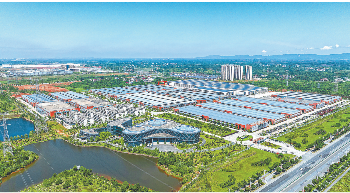
航拍位于上饶经济技术开发区的江西一舟数据技术有限公司厂房。
