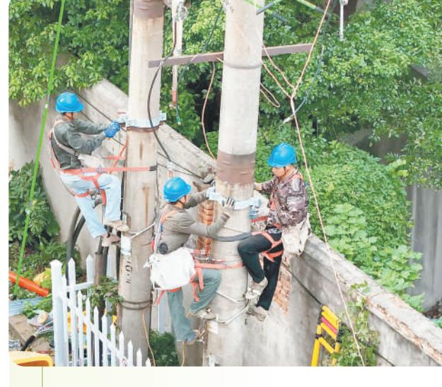
近日,在南昌市青山湖区丰源天域小区配电变压器改造现场,国网江西省电力有限公司南昌市青山湖区供电公司工作人员冒着酷暑,采用低压发电车并网新技术,全程不断电更换变压器,确保周边居民及商户正常用电。
