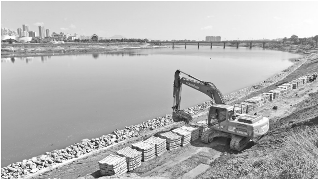
9月7日，在永丰县恩江镇岭上村，工人正在对乌江河堤进行生态护岸施工。
