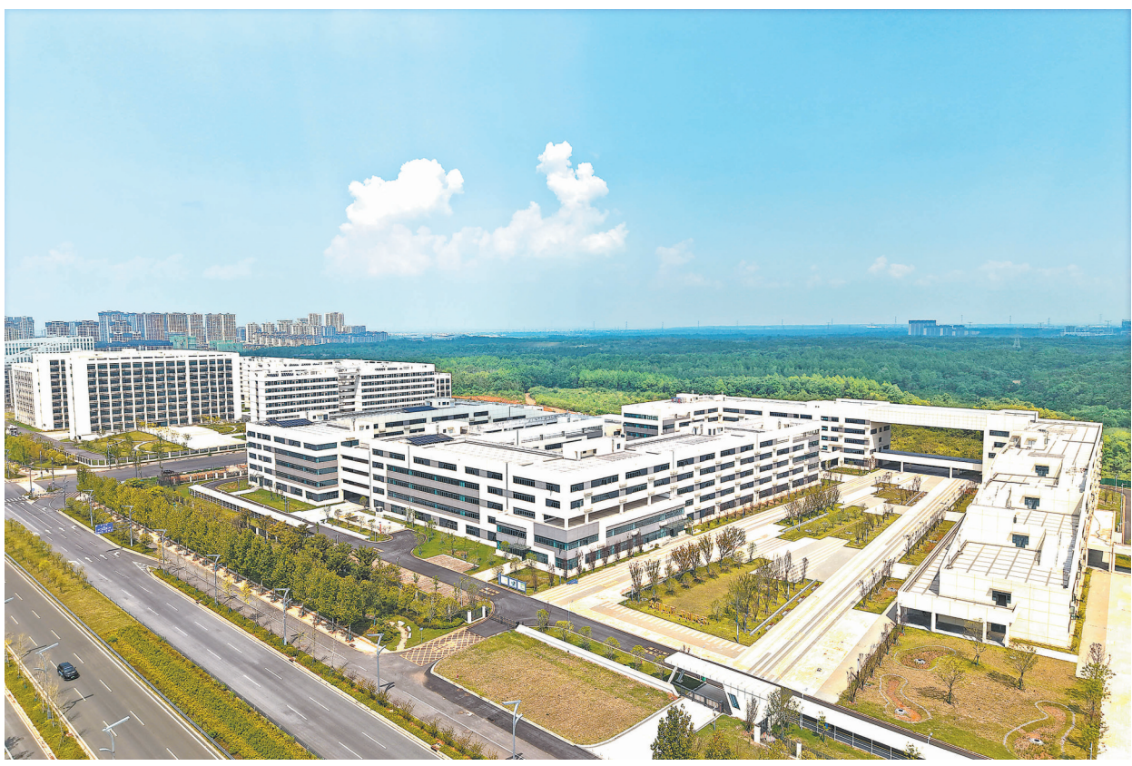
9月17日，赣江新区国家级数字技能人才培养基地三期——技工学校西区项目通过竣工验收。该项目以智能化、数字化、生态化特色，采用装配式建造技术，总建筑面积15.3万平方米，可容纳5600名学员。 本报全媒体记者 郑莹摄
