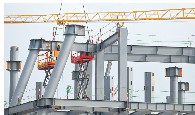
9月29日，由中国二十二冶集团江西公司承建的九江市科技文化产业园项目一期正在进行主体结构施工。国庆中秋假期，工人坚守岗位加紧建设，预计10月底实现主体结构封顶。 本报全媒体记者 吴文兵摄
