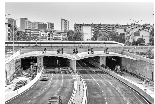
9月30日，南昌市青云谱区广州路下穿京九铁路隧道正式通车。该项目向西联系九洲大街，向东对接广州路，整体形成跨片区联系朝阳、城南、南昌东站等主城片区、外围组团的东西向大通道。
