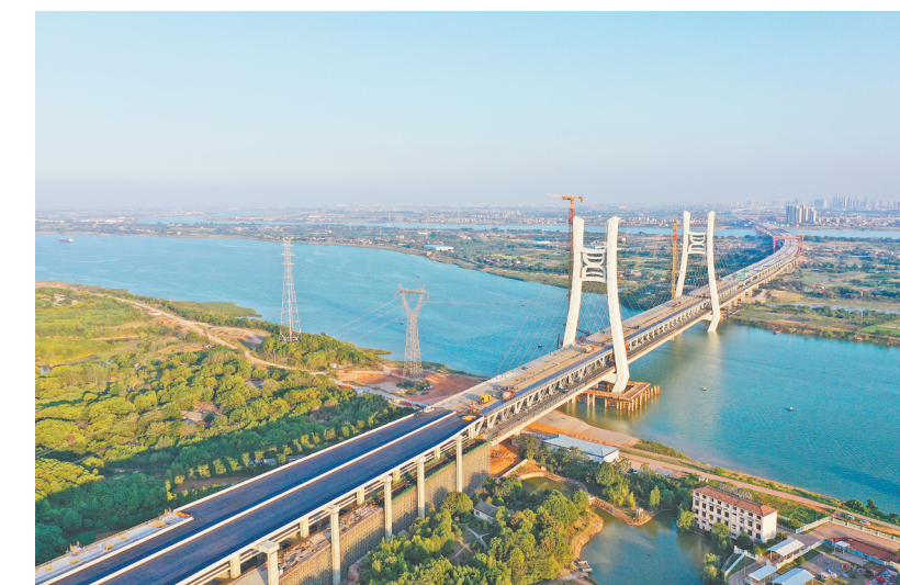
目前，南昌市隆兴大桥已进入收尾阶段，工人们正加紧建设，全力冲刺今年年底公路通车目标。图为10月10日，工人正在进行桥面沥青摊铺及安装附件等作业。 本报全媒体记者 洪子波摄
