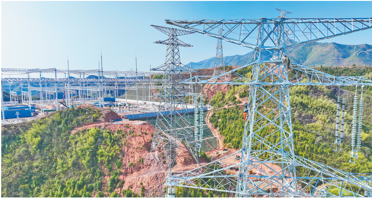
10月9日，在赣州市章贡区赣州北500千伏输电工程项目现场，机械轰鸣、施工人员忙碌作业，赶工期、抢进度，加速推进重点项目建设。 特约通讯员 胡江涛摄
