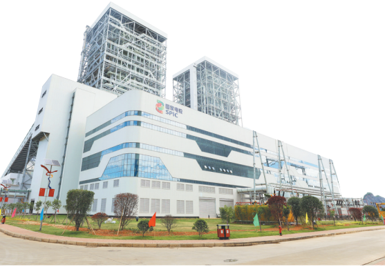
国家电投分宜发电厂扩建项目
