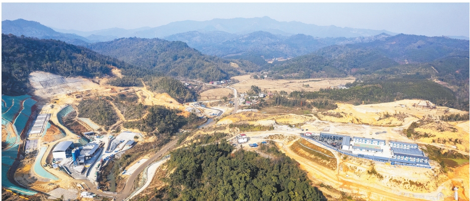
大岗山水利枢纽工程现场 赵春亮摄
