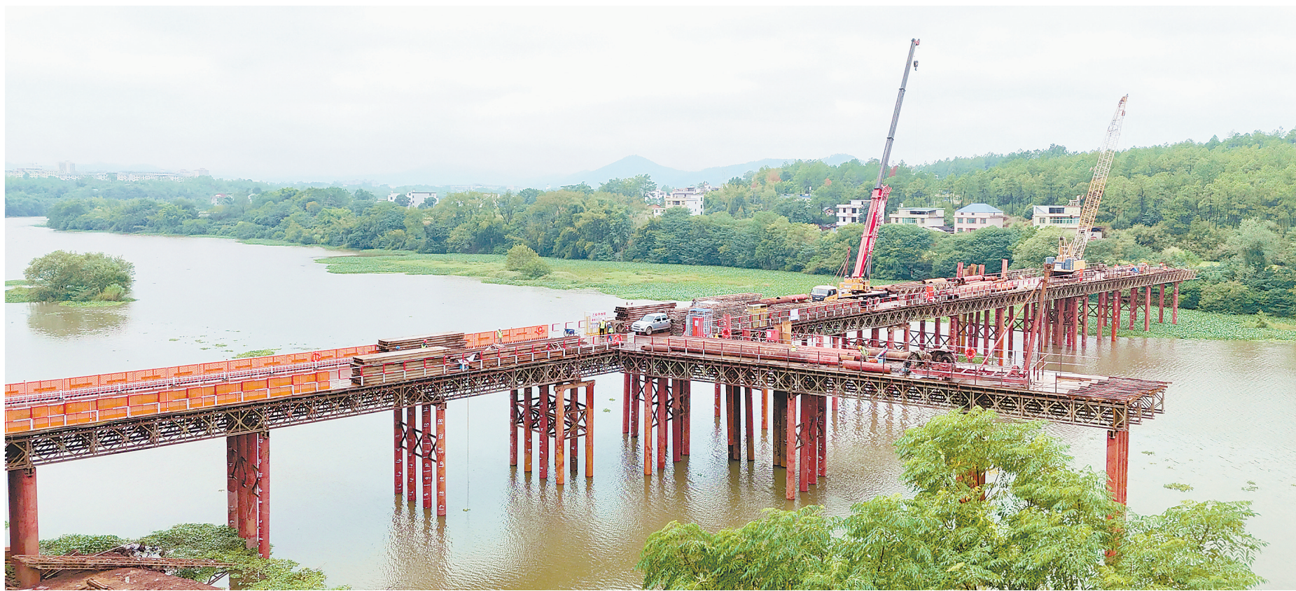
10月22日,济广与厦蓉高速会昌联络线项目绵江大桥建设现场,工人正在抓紧施工。据了解,该项目建成后,将实现会昌县融入赣州“1小时经济圈”。
