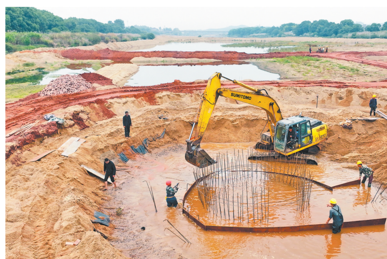
11月5日，永丰县恩江镇文江村恩江河段，工人正在进行水源地保护工程施工。近年来，永丰县加大河湖流域水生态环境保护力度，让水更清、河更畅、岸更绿、景更美。通讯员 刘浩军摄
