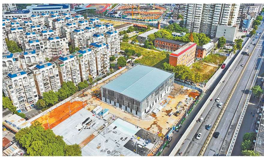
正在建设中的南昌市东湖区社区嵌入式体育场。
