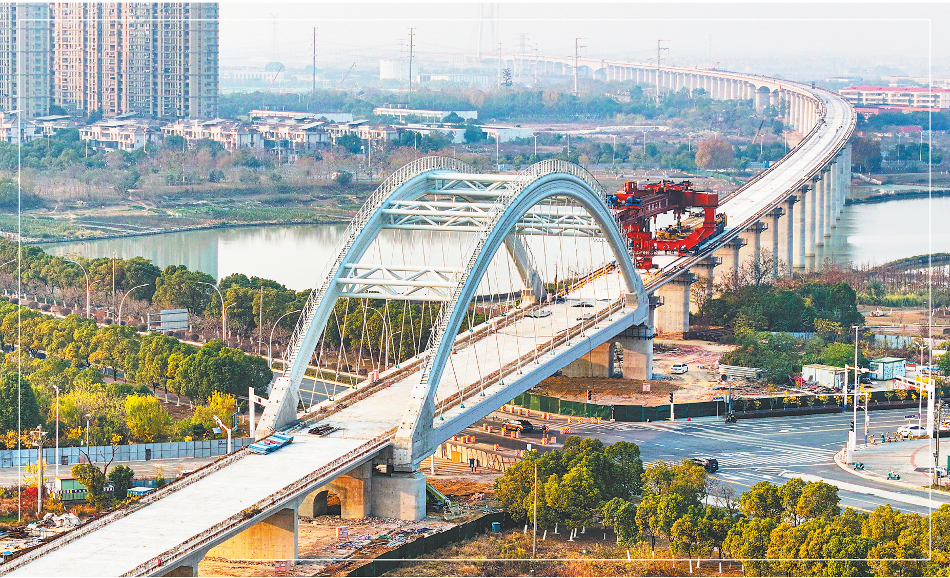
12月9日，随着最后一孔预制箱梁的精准架设，昌九高铁南昌隆兴大桥预制箱梁全部架设完成，为项目全线建成通车奠定了坚实基础。 本报全媒体记者 张翰林摄
