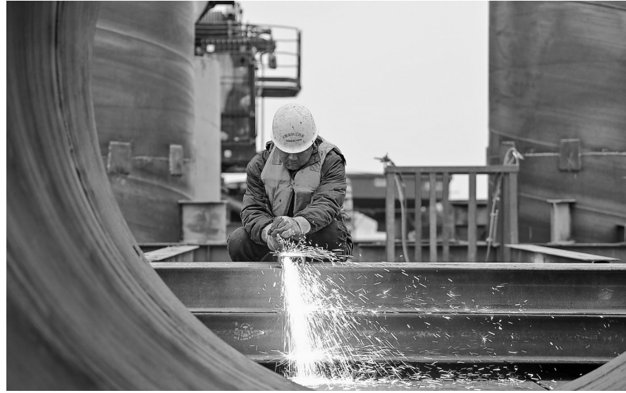
1月1日，长赣高铁江西段赣州赣江特大桥施工现场，施工人員坚守岗位，铆足干劲，建设工作稳步推进。 特约通讯员 胡江涛摄
