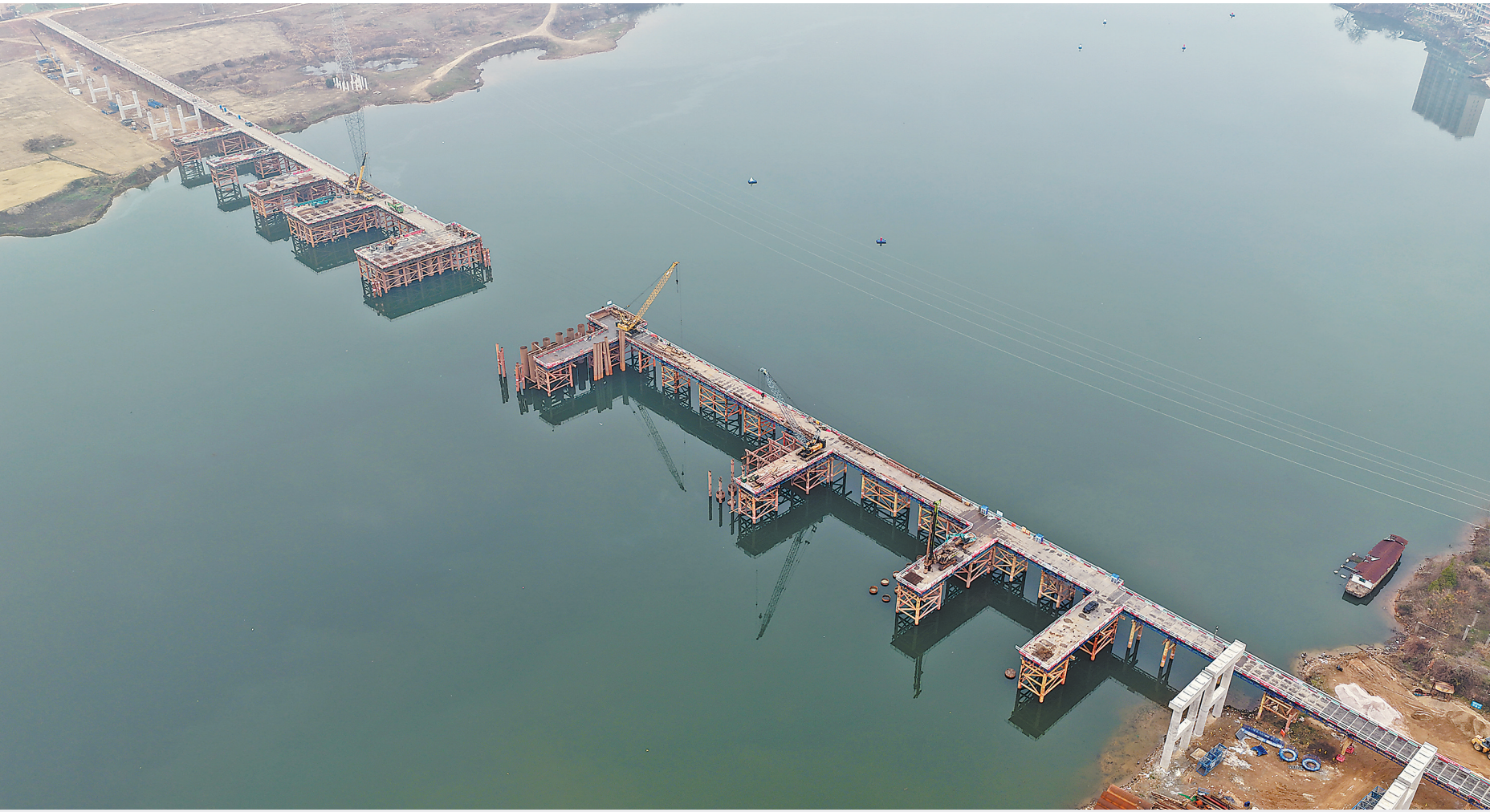
1月29日，新黄金埠特大桥建设现场的施工画面。地处余干县黄金埠镇与梅港乡境内的新黄金埠特大桥全长1193米，横跨信江，是G236芜汕线余干县黄金埠段改建工程的核心控制性工程，总投资超4亿元。该桥于2025年开工，预计2027年竣工通车。
