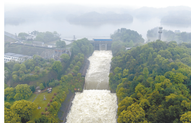
4月13日，新余市江口水库开启单孔闸门泄洪。连日来，新余市持续出现降雨天气，江口水库水位快速上涨，当地水利部门适时开闸泄洪，科学调控水位，筑牢防汛安全网。
