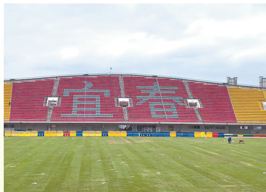
4月23日，宜春体育中心体育场焕然一新。 本报全媒体记者 邹海斌摄
