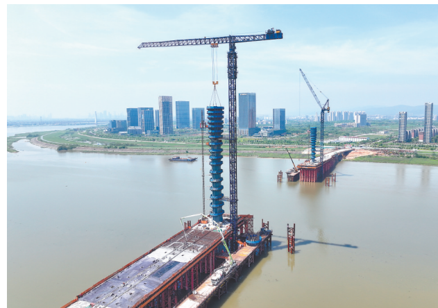
4月26日，赣江新区汇贤大桥施工现场一派繁忙，工人正在浇筑桥面混凝土，全力推进大桥建设。据了解，该桥计划于今年12月全线贯通。 本报全媒体记者 洪子波摄
