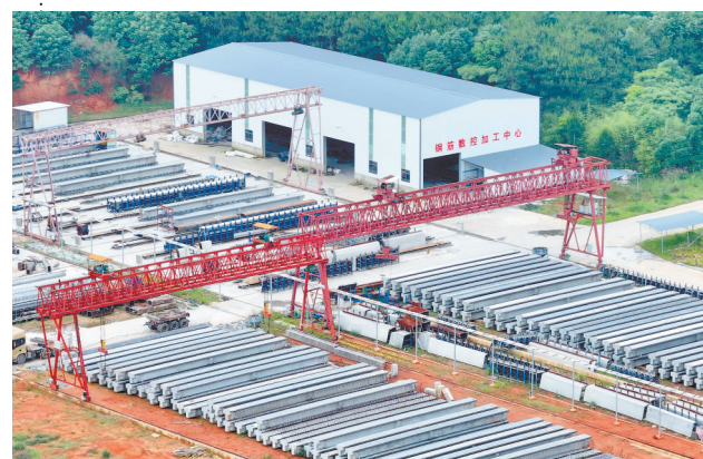
5月23日，泰和县溪滨建材有限公司智慧梁场加紧生产预混梁，保障桥梁项目建设用梁需求。 通讯员 邓和平摄
