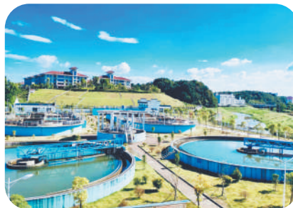
南昌洪崖环保有限责任公司污水处理厂区
