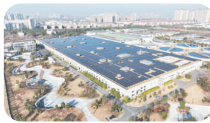
江西洪城城东污水处理厂有限公司厂区
