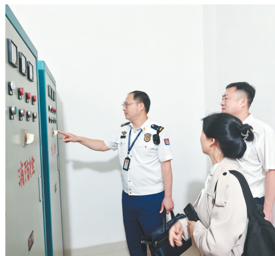
6月10日，抚州市临川区消防救援大队以全国“安全生产月”为契机，走进辖区企业排查消防安全隐患，手把手指导企业员工开展设备检查与隐患排查工作。胡彪摄
