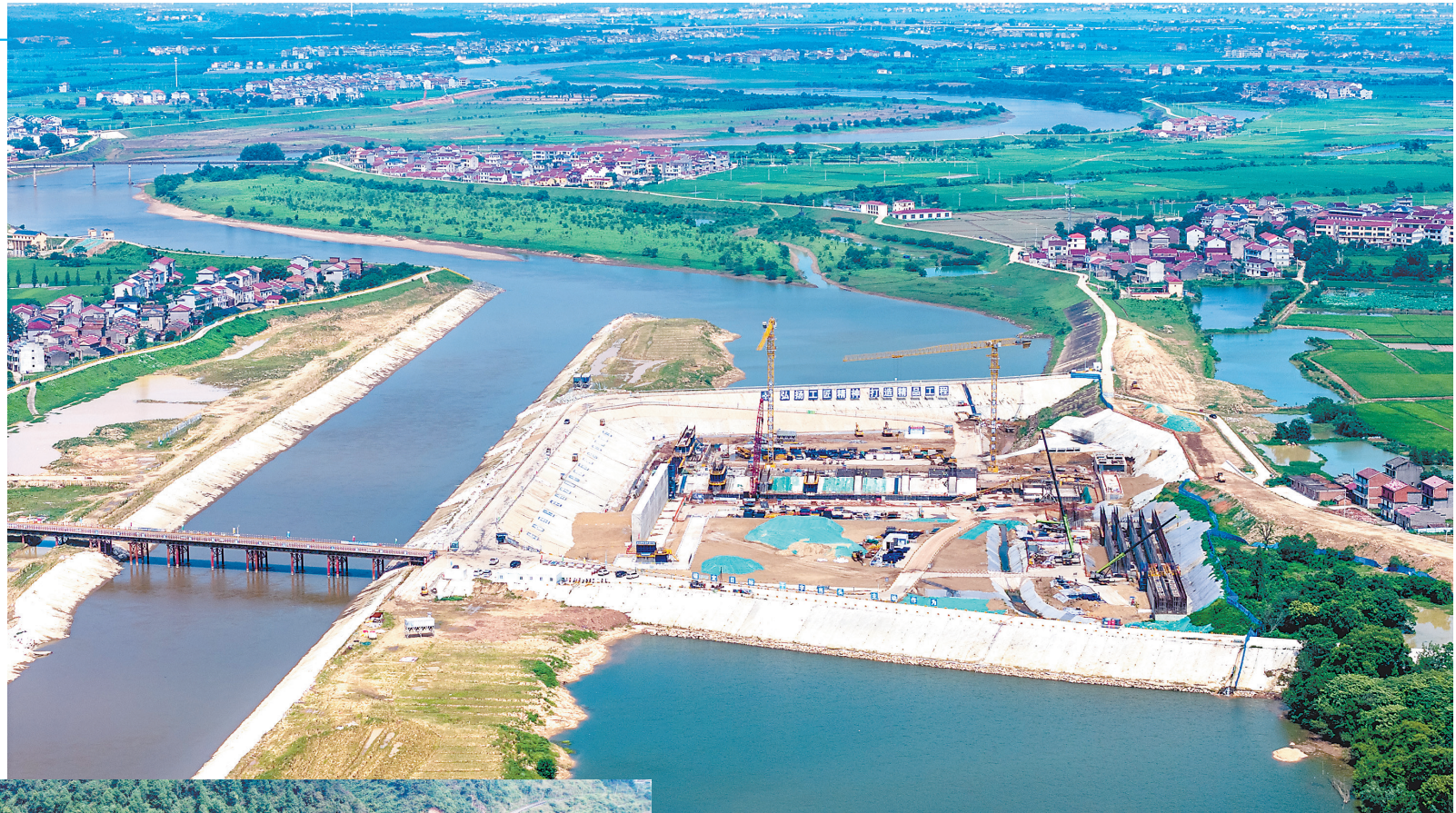
▲6月22日，樟树市昌傅镇袁河航道提升工程龙尾洲枢纽施工现场，工人正在进行鱼道及泄水闸施工作业。据了解，袁河航道提升工程项目完工后，将补齐赣西水运基础设施短板，降低沿线企业物流成本，优化区域交通运输结构，助推地方经济社会高质量发展。 通讯员 周亮摄
