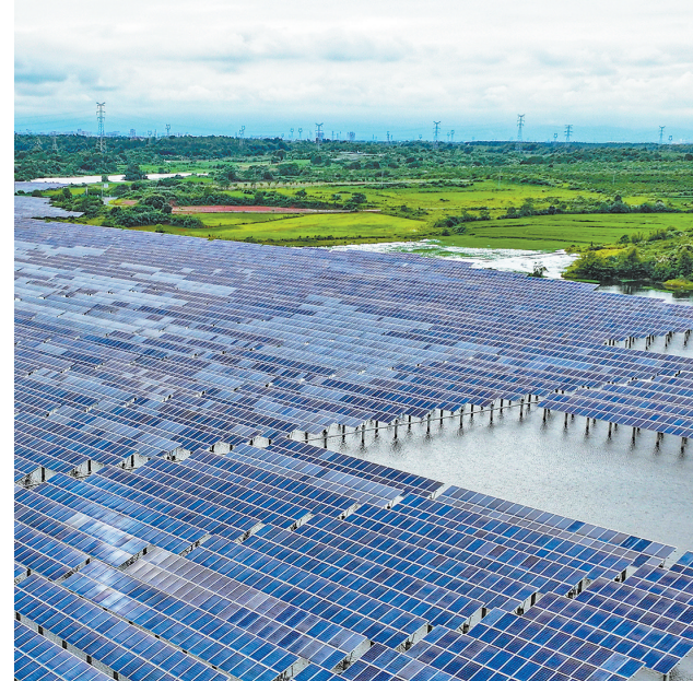
6月23日,航拍奉新县宋埠镇与赤田镇交界的2000余亩渔光互补基地,水面上连片光伏板持续输出绿色电能,水下同步开展生态水产养殖,实现生态效益与经济效益双赢。 本报全媒体记者 张翰林摄
