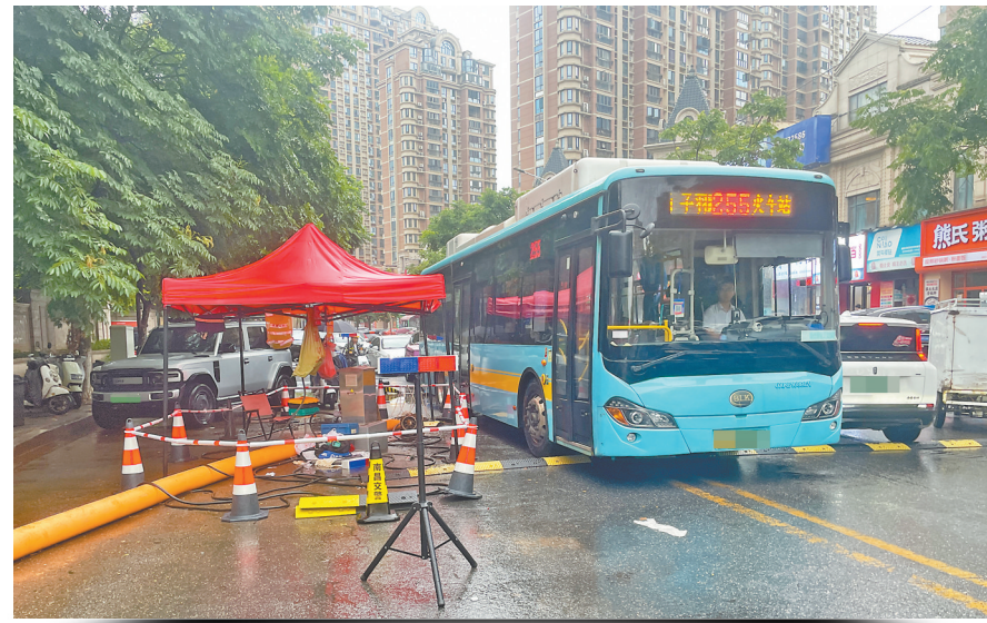
公交车被迫跨线绕过抽水设备驶入对向车道。
