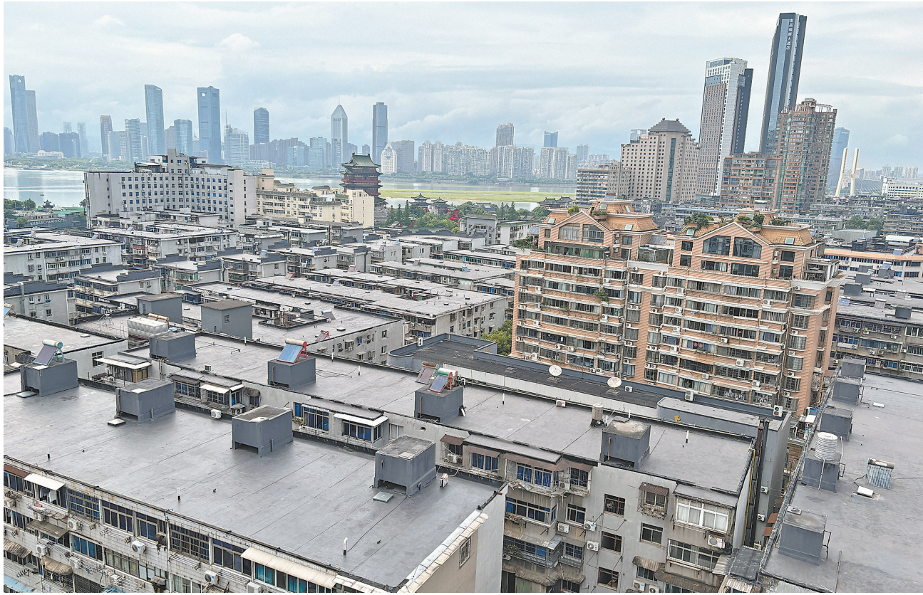
翻新后的楼顶焕然一新。
