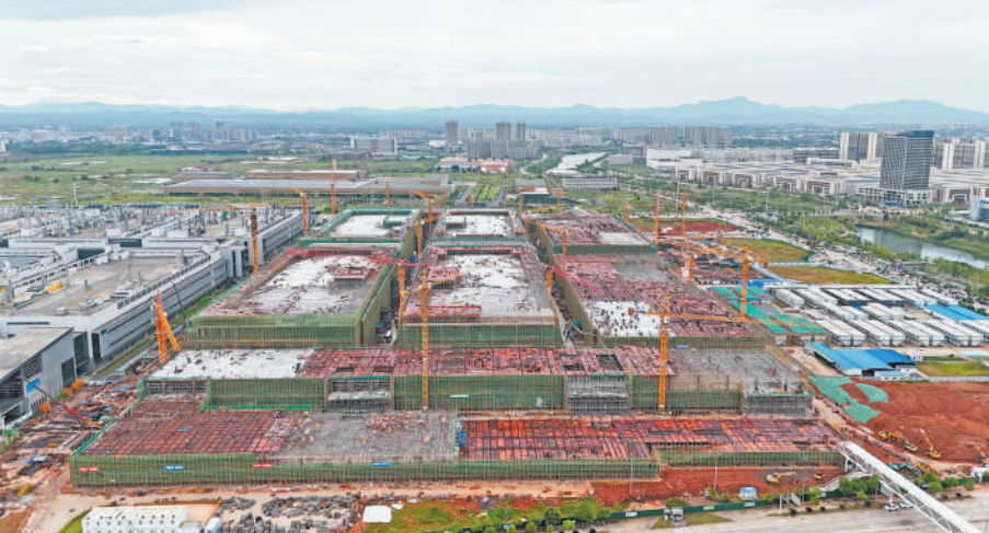
近日，工业富联（赣州）智能制造二期项目B01、B02栋厂房迎来主体结构封顶，标志着项目建设取得阶段性重要成果。该项目以“灯塔工厂+数字制造平台”为目标，加速智能化升级。建设期间，项目建设单位赣州市产控集团全程跟踪、蹲点推进，合力破解各环节难题，全力保障项目建设高质高效推进。
