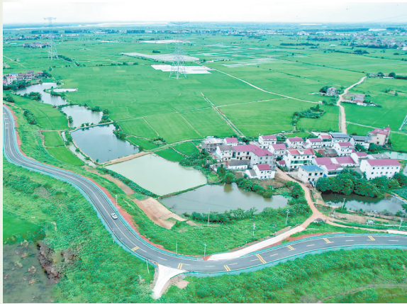
俯瞰环鄱阳湖堤顶公路应急保通工程南昌县泾口乡段,一条集防洪安全、农村交通、文旅融合于一体的生态经济走廊映入眼帘。 通讯员 杨 健彬
