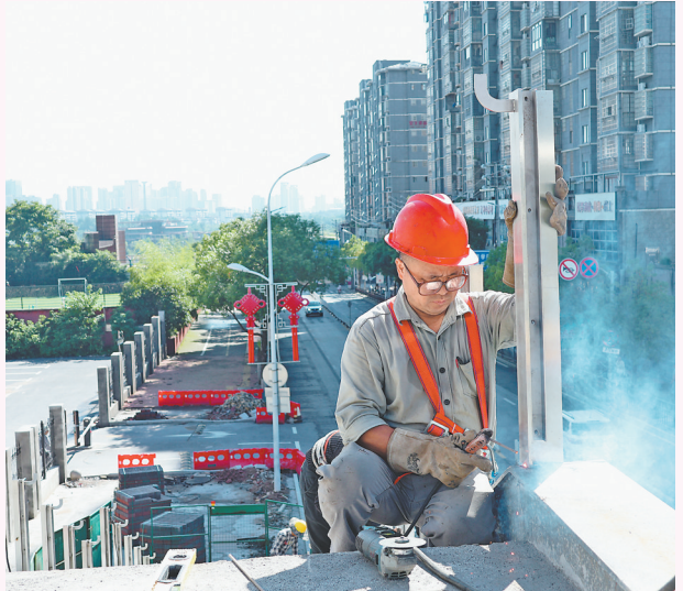
施工人员在抢抓工期安装人行天桥护栏。
