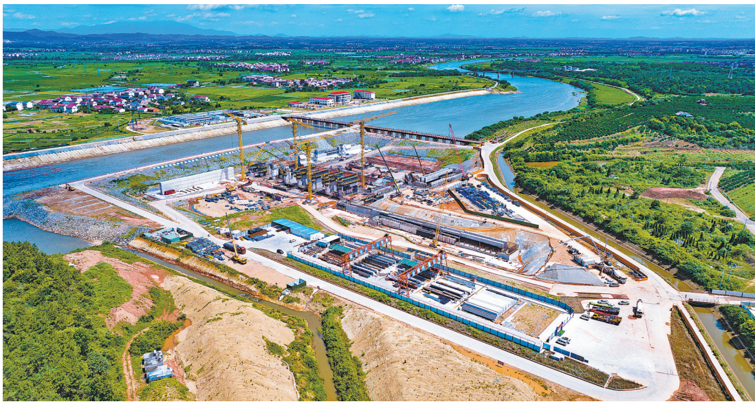
袁河航道提升工程笏洲枢纽泄水闸首个闸墩顶浇筑施工现场。
