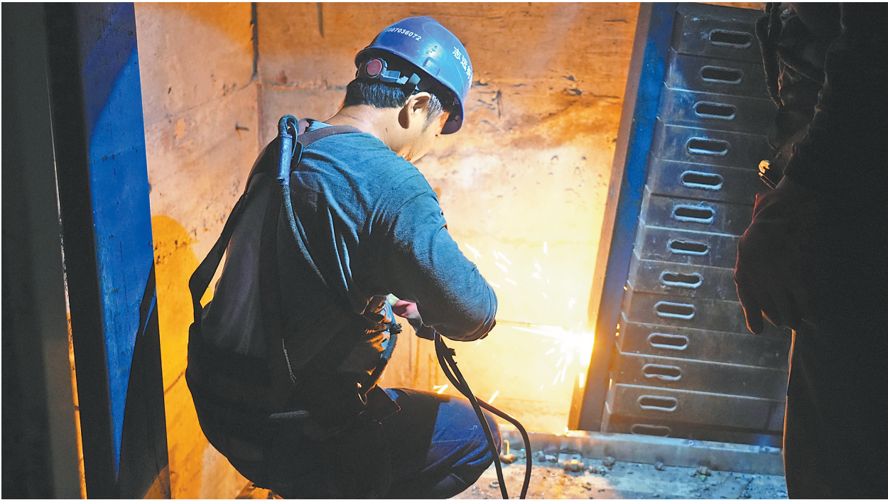
工人正在电梯井内进行旧电梯拆除工作。
