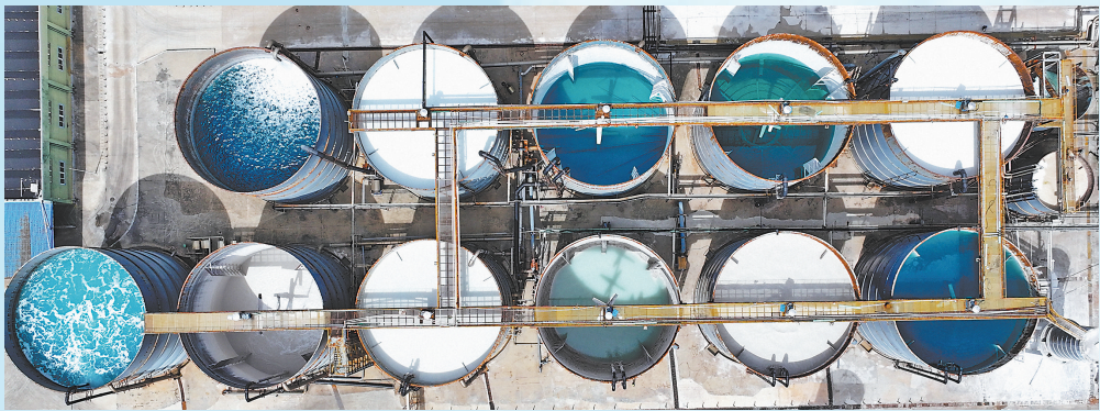
通过深井水溶采卤工艺,地下800米至1300米的天然岩盐被溶解为卤水。
