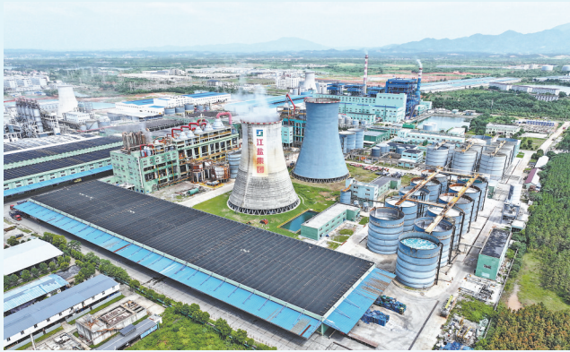
卤水到达制盐生产区后,经化学沉淀、精密过滤、蒸发结晶、干燥筛分等环节制备成食盐。
