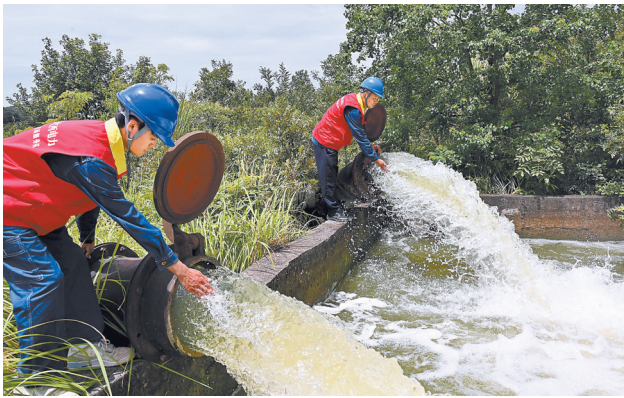
7月30日，国网江西电力金溪县井冈山先锋共产党员服务队深入琉璃乡渡塘村电力提灌站，开展设备隐患排查、安全用电科普等志愿服务，全力保障夏季农田灌溉用电安全稳定。通讯员 邓兴东摄
