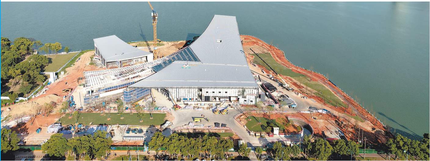
▲建设中的南昌市图书馆新馆。本版图片由本报全媒体记者 周珺摄
