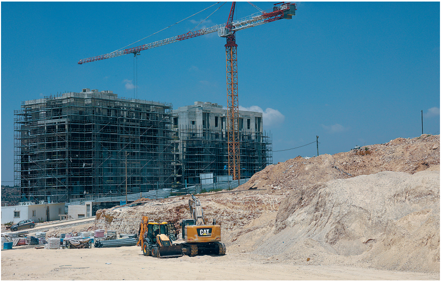
这是 8 月 9 日在耶路撒冷附近拍摄的约旦河西岸一处建设中的犹太定居点。近日,以色列在约旦河西岸进一步实施犹太定居点建设。 新华社发(吉尔·科恩·马根摄)
