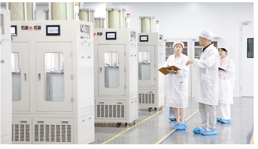
江西固芯能源有限公司生产车间内,工作人员正在检查设施运作情况。(青原区融媒体中心供图)
