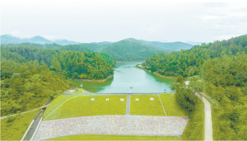
青原区长长坑水库除险加固后照片。通讯员 袁 焱摄
