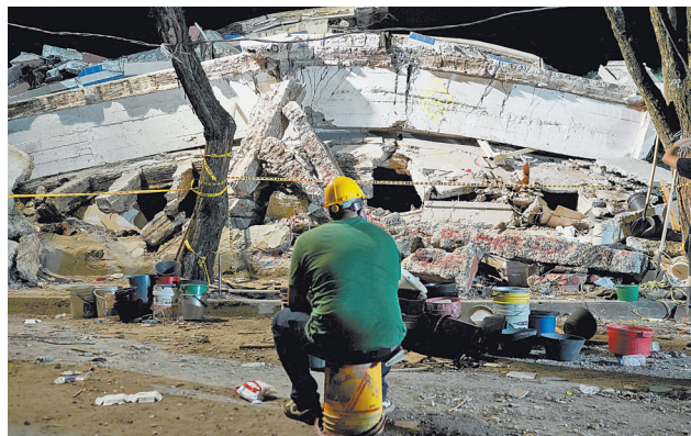
8月11日,在哥伦比亚卡利,一名男子坐在倒塌的建筑物废墟旁。哥伦比亚全国首府协会8月11日发布最新统计显示,10日在该国西部发生的7.4级强震已造成188人死亡、1677人受伤。 新华社/路透
