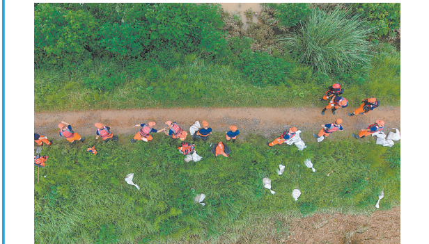
这是8月13日拍摄的河南省平顶山市郏县长桥镇北汝河段民堤溃口抢险作业现场(无人机照片)。新华社记者 杨鑫鑫摄
