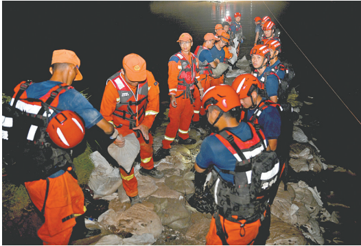
这是8月13日拍摄的抢险作业现场。
