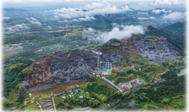
金石山矿山公园全景。
