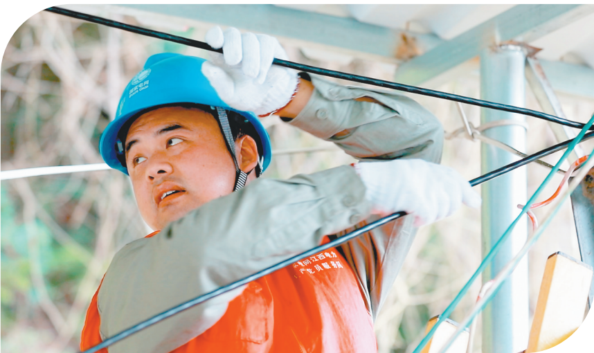
国网江西电力（萍乡蓝翔）井冈先锋共产党员服务队在驿马村为村民饮水工程更换老旧线路。
