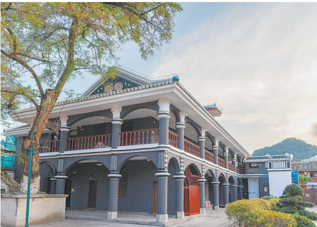
这是遵义会议会址（8月17日摄）。 近日，遵义会议会址保护修缮项目持续推进，目前工程即将完工。 新华社记者 刘 续 摄
