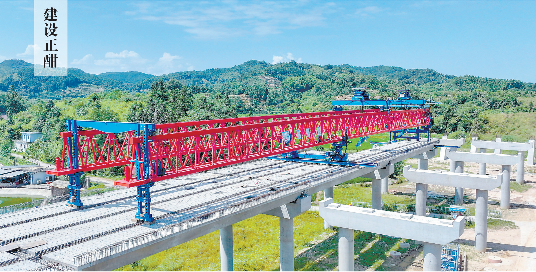
8月25日,由中建集团承建的弋阳至南丰高速公路7标段(南丰段)施工现场,施工人員正有序开展桥梁架设作业。项目建成后,将串联沪昆、抚吉、福银、济广等多条高速主干线,畅通区域交通脉络、完善全省综合交通网络,有效提升路网通行效能与区域互联互通能力,助力沿线经济高质量发展。 通讯员 邓 鹏摄
