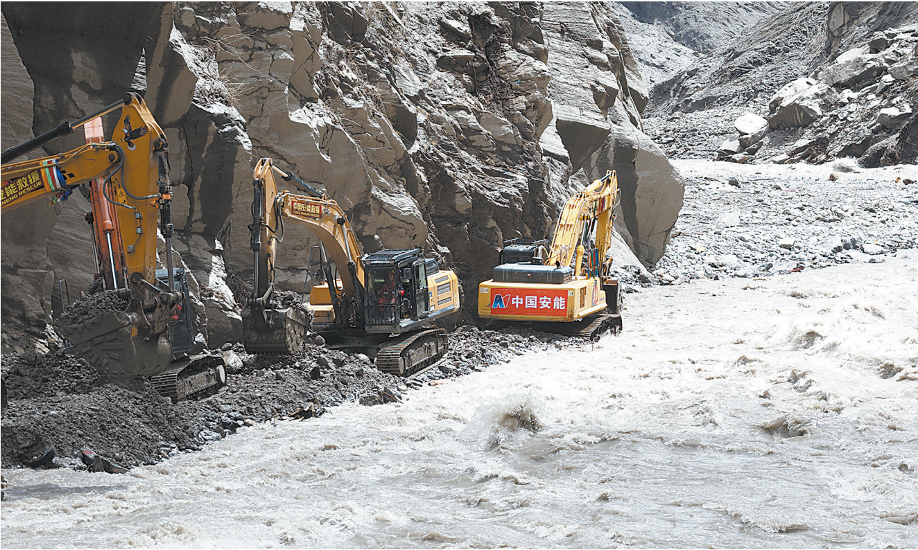
8月29日,应急管理部调派中国安能工程力量持续开展道路抢通作业,投入60名技术和技能骨干,调集挖掘机、装载机 etc 等14套工程救援装备,对G216国道损毁路段全力开展抢通作业。 新华社记者 姜 帆摄
