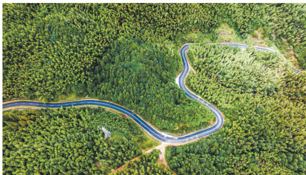
近日，奉新县石溪至柳溪段的九百公路路面提升改造工程完工。乡村公路在崇山峻岭间蜿蜒。近年来，奉新县持续推进乡村公路建设，全方位提升公路通行能力，为乡村振兴提供交通保障。
