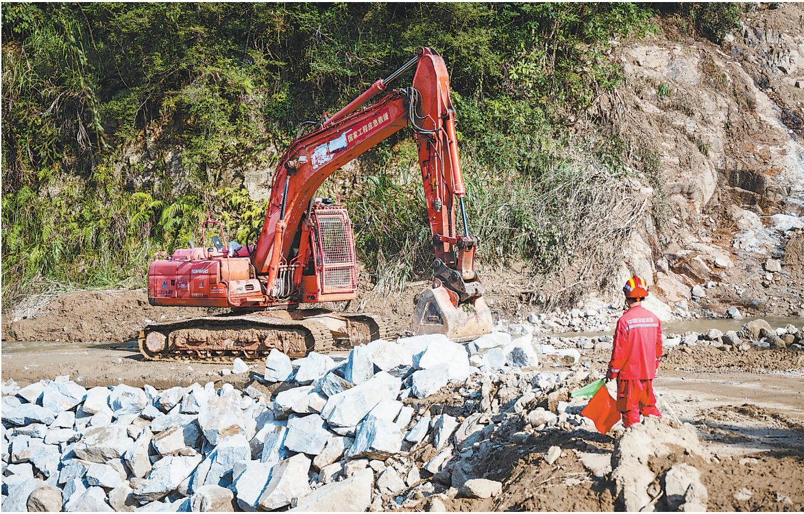
9月7日，遂川县高坪镇，距明坑村3公里外，中国安能二局施工人员正在对30米受损边坡实施修复加固，及时消除边坡坍塌隐患，全力保障受灾区域道路通行安全。
