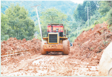
调集挖掘机、装载机、自卸车等设备投入抢险保通工作。
