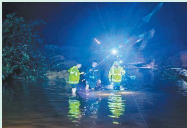
养护所党员突击队第一时间进入现场勘察塌方情况。
