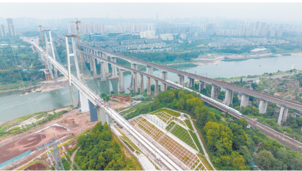
这是9月14日拍摄的成渝中线高铁建设现场(无人机照片)。当日,随着最后一段无砟轨道道床板浇筑完成,标志着成渝中线高铁全线无砟轨道建设顺利完工,为成渝中线高铁全线按期通车奠定了坚实基础。 新华社发(欧阳开源摄)
