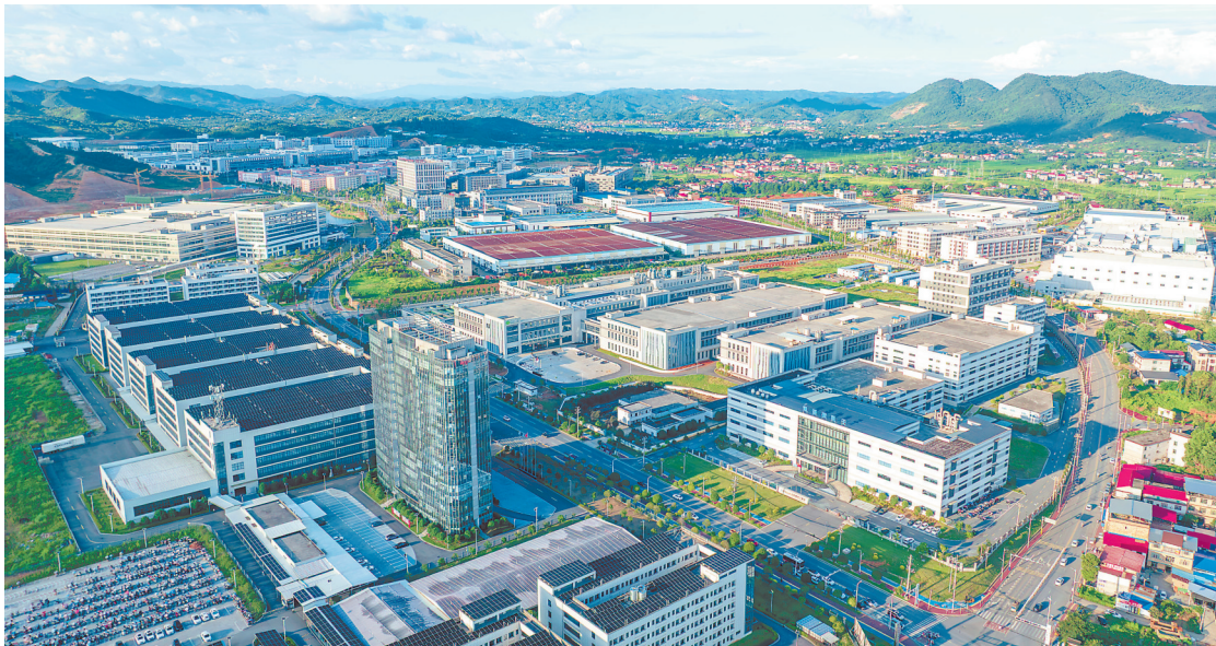
在赣湘合作产业园内，PCB产业链企业厂房林立、集群连片。 通讯员 欧阳林摄
