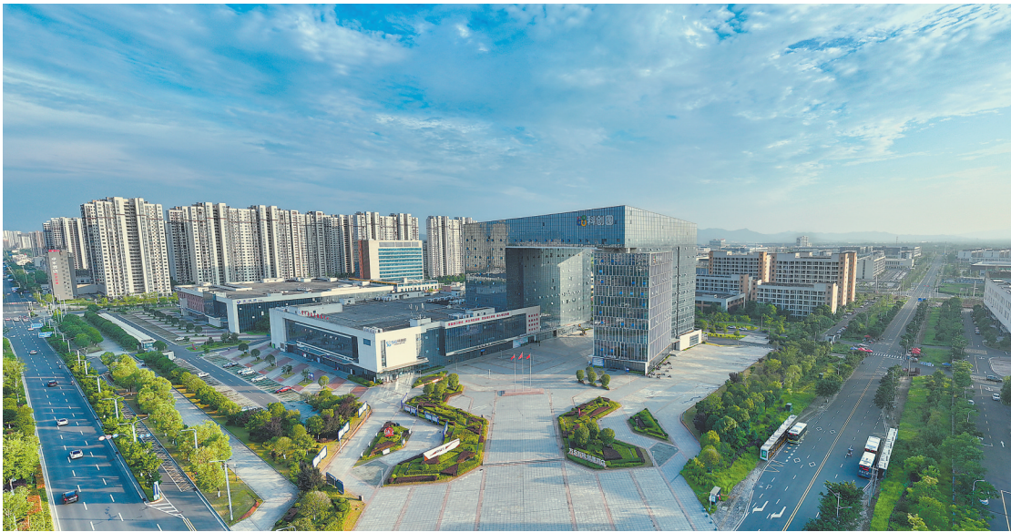
信丰县5G智慧产业园。（信丰县融媒体中心提供）
