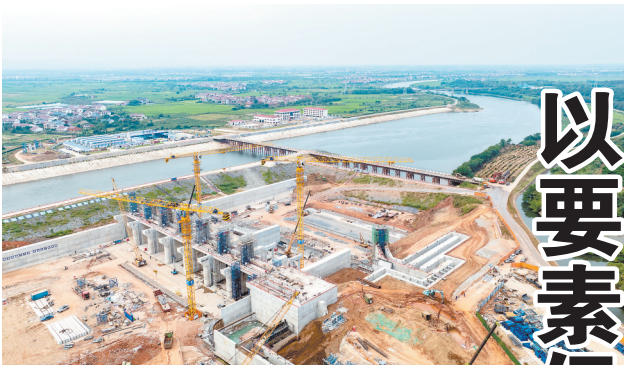
袁河航道提升工程笏洲枢纽施工现场。
